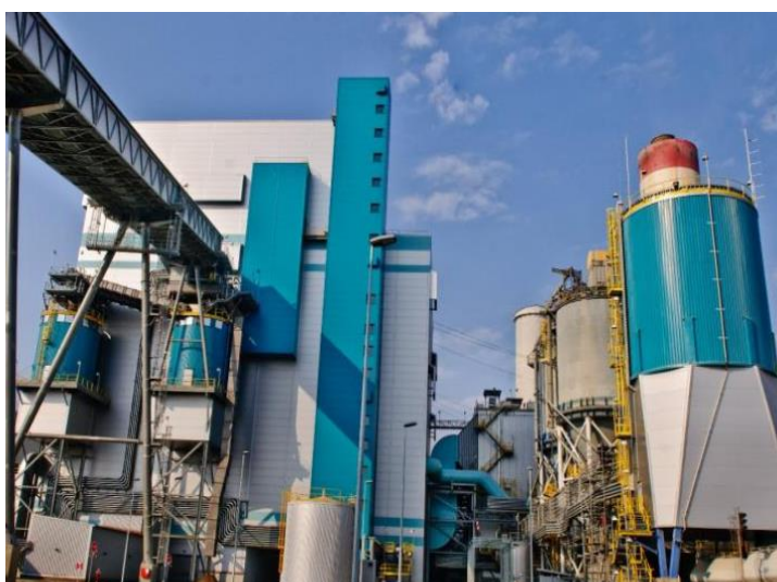
Rysunek 8. Wykorzystanie biomasy w postaci zrębków: a) gałęzie na przyzbie w sadzie, b) przyzma zrębków po rozdrobnieniu, c) transport zrębki drzewnej do zakładu energetycznego, d) blok Elektrowni Połaniec zasilanej biomasą [15] (fot. A. Dyjakon)
